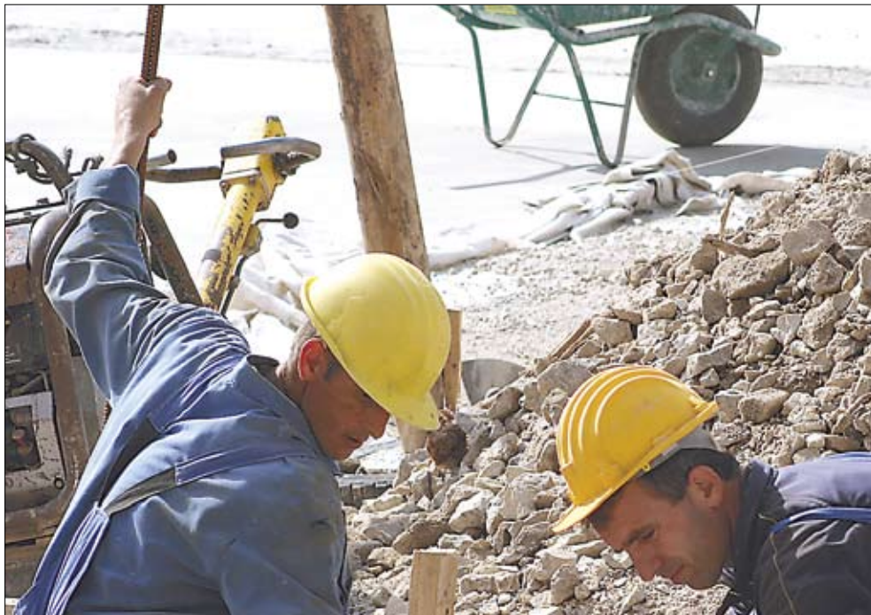
Kevés a kőműves, ács, burkoló és vasszerelő, egyes munkák elvégzésénél fennakadások tapasztalhatók
